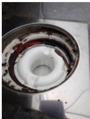
Påvist membran i sluk, under klemring
