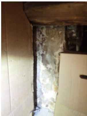
Eldre pipe som ikke er i bruk.
