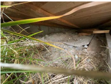
Fundament av leca og betong under baderomsgdelen.
