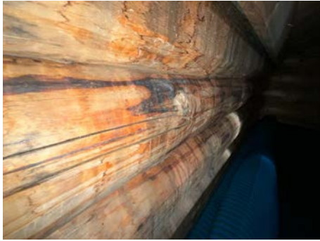
Utsnitt fuktmerker på tømmerkasse.
