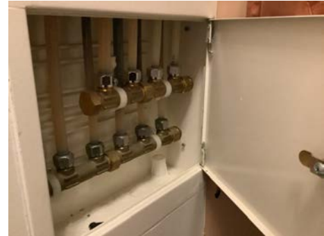
Fordelerskap til rørøppegget.
