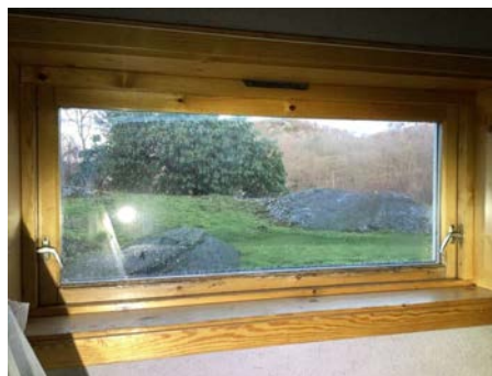
Punkttert vindu i kjellerbod
