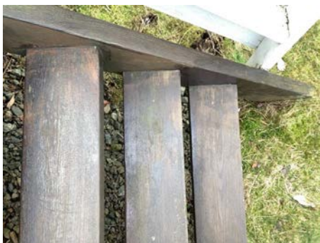
Store åpninger i trinn
