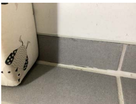
Enkelte mykfuget må påregnes utskiftet
