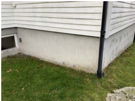
Krypkjeller under tilbygg
