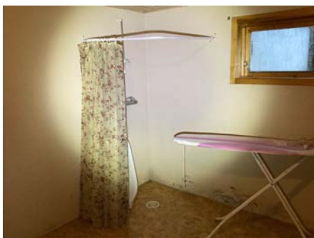
Oversikt vaskerom i kjeller
