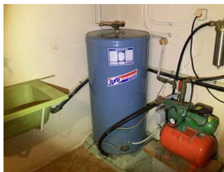
Varmtvannstank
