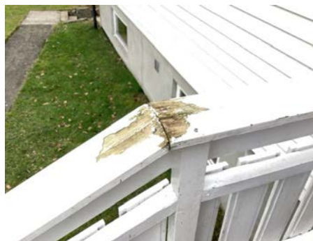
Skader på topprekke
