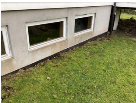
Utvendig grunnmurplast
