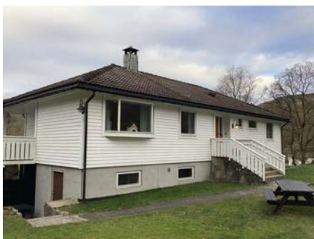
Tekking fra byggeår
