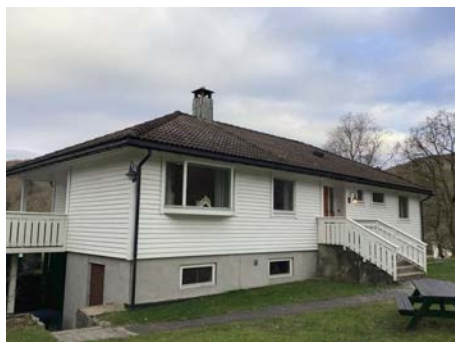
Taket har ikke snøfangere
