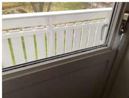
Kondensering på balkongdør
