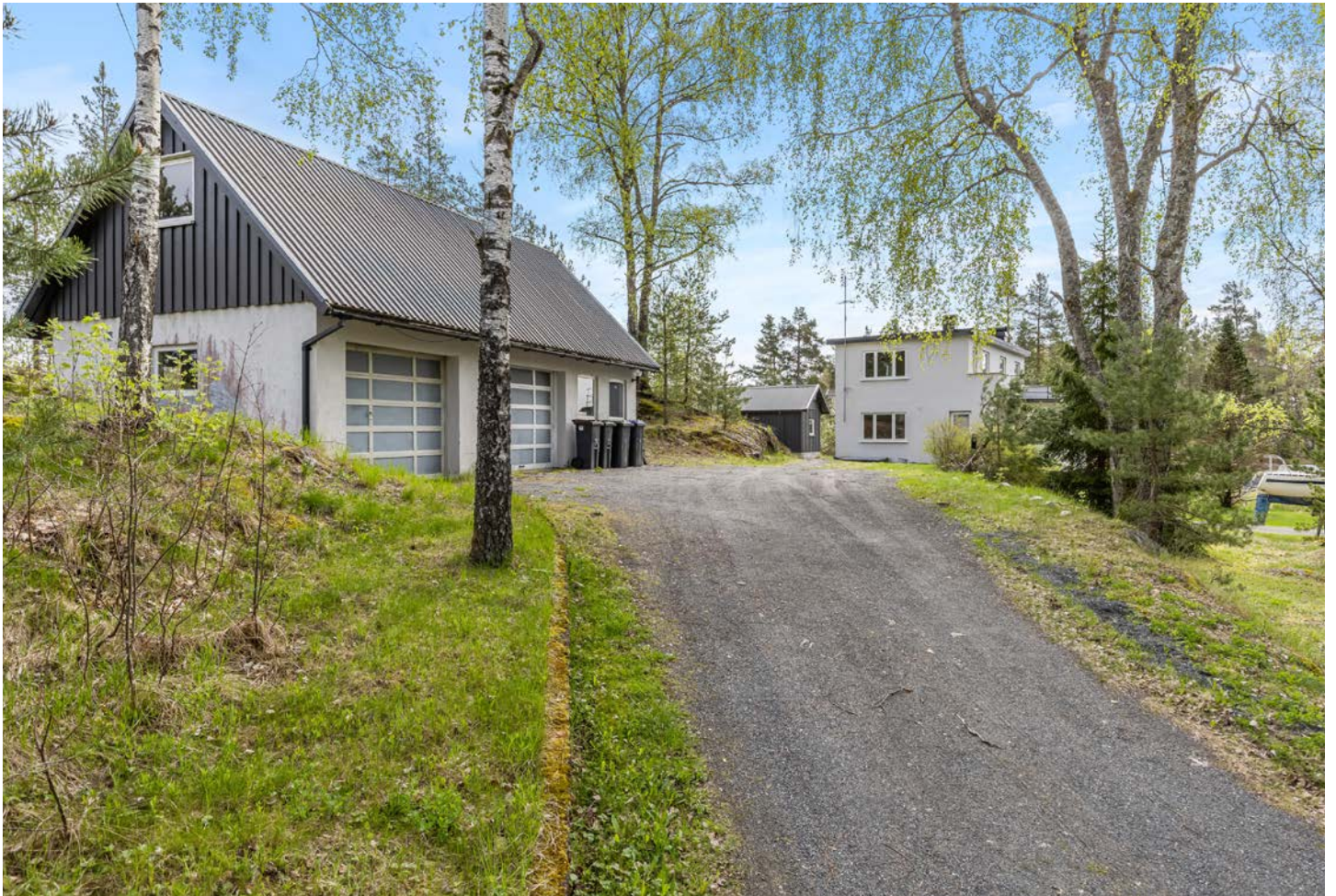
Velkommen til Tuftene 1 i Gjerstad! Tilhørende dobbelgarasje med loft
