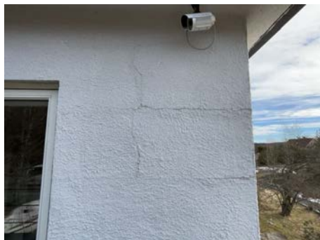
Spenningsriss i pussede overflater.
