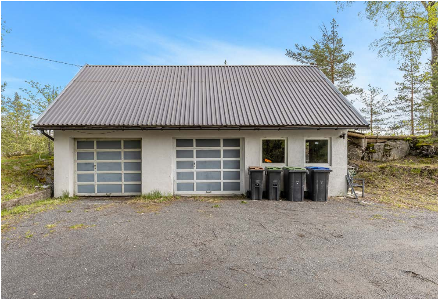
Det er godt med parkeringsplass på tomten samt i tilhørende garasje
