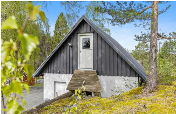
Perfekt for ekstra lagring over garasjen. Eget loft over garasjen på ca. 29 kvm.
