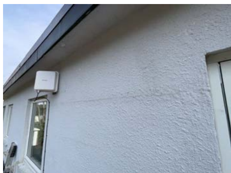
Spenningsriss i pussede overflater.
