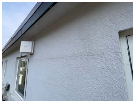
Spenningsriss i pussede overflater.
