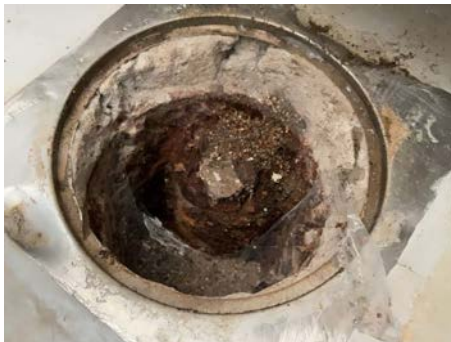
Hjelpesluk med rustsvekkelser - Kjellerbod / teknisk rom.
