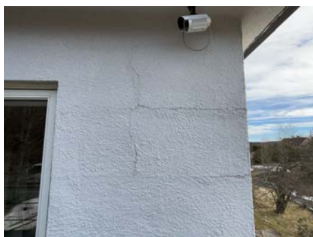
Spenningsriss i pussede overflater.
