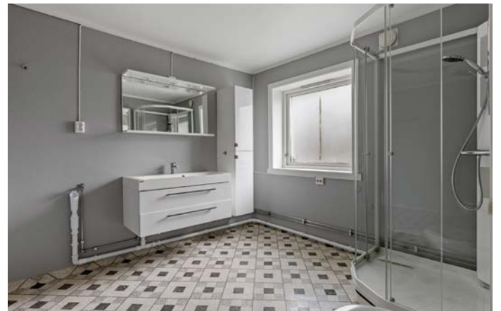
Kombinert bad / vaskerom i boligens 1. etasje. Veggflatene er utført med malt strietapet. Vegghengt toalett, servantinnredning, dusjhjørne og
