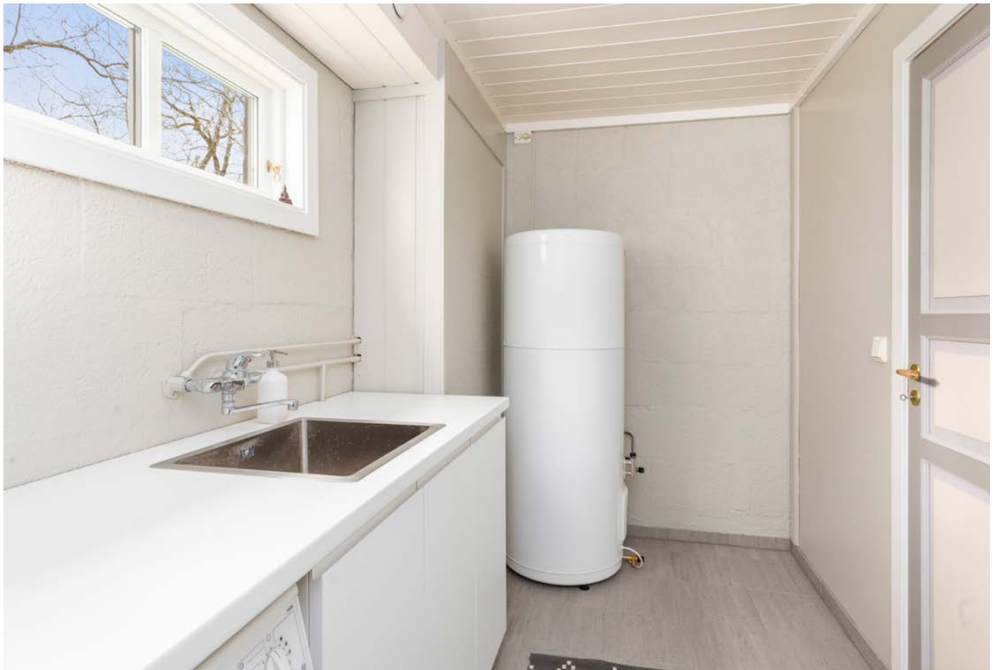
Vaskerom i kjeller.
