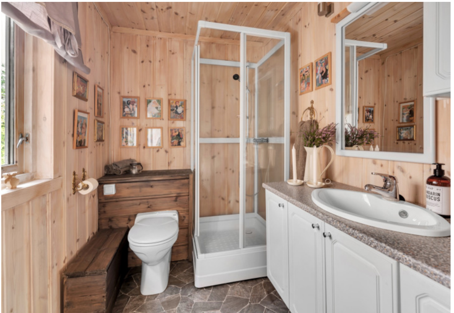
Toalettrom med vakuumtoalett med kvern. Tilkoblet tank med jutesekk utenfor. Baderomsinnredning fra Norema med nedfelt servant
