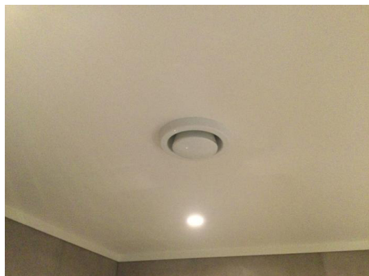
Balansert ventilasjon.
