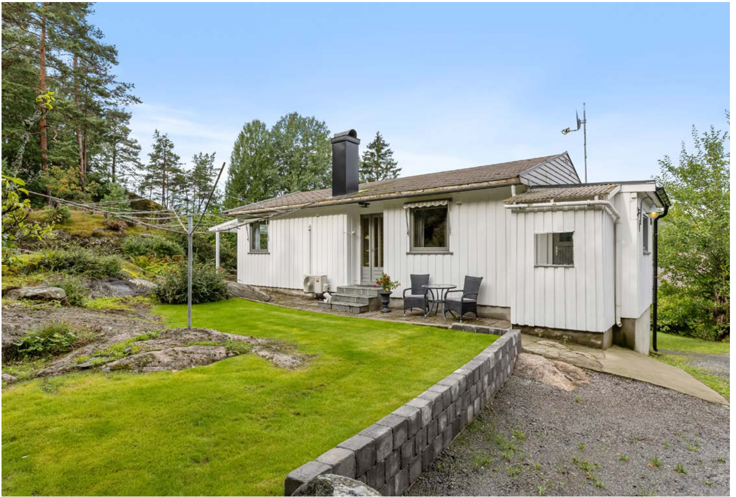
Parkeringsplassen er nylig utvidet og det er satt opp mur mot hagen
