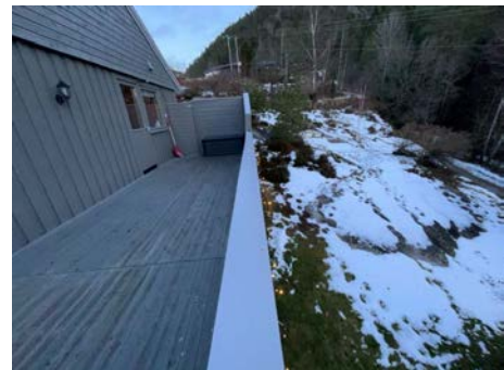
Foto viser noe skjevheter/bøy mellom rekkverk og skillevegg.
