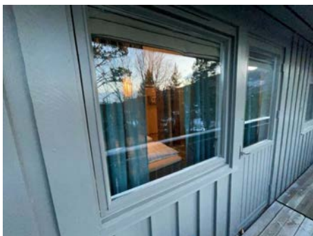
Eks. på eldre vinduer.
