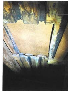
Undertak med synlig sutak.
