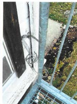
Ståltrapp er løs og må festes. Krav til rekkverk er ikke tilfredsstillende.
