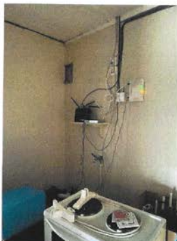
Eks. på koblingspunkt for svakstrøm/data og strøm.
