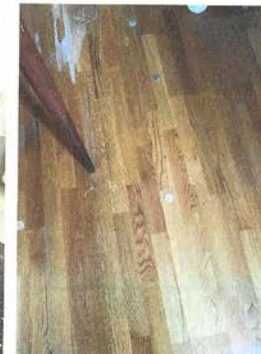
Eksempel på propper i gulv i 2. etg.
