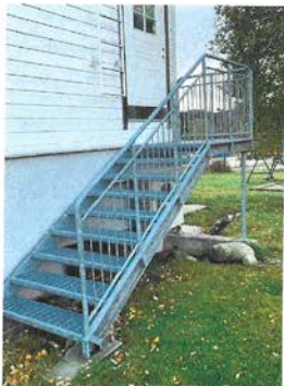
Ståltrapp er løs og må festes. Krav til rekkverk er ikke tilfredsstillende.
