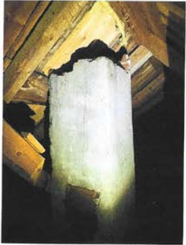
Pipe fjernet til underside av undertak.
