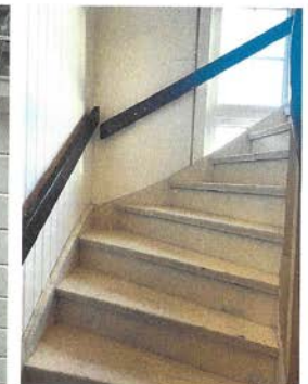
Trapp forbi vindu uten sikkerhetsglass
