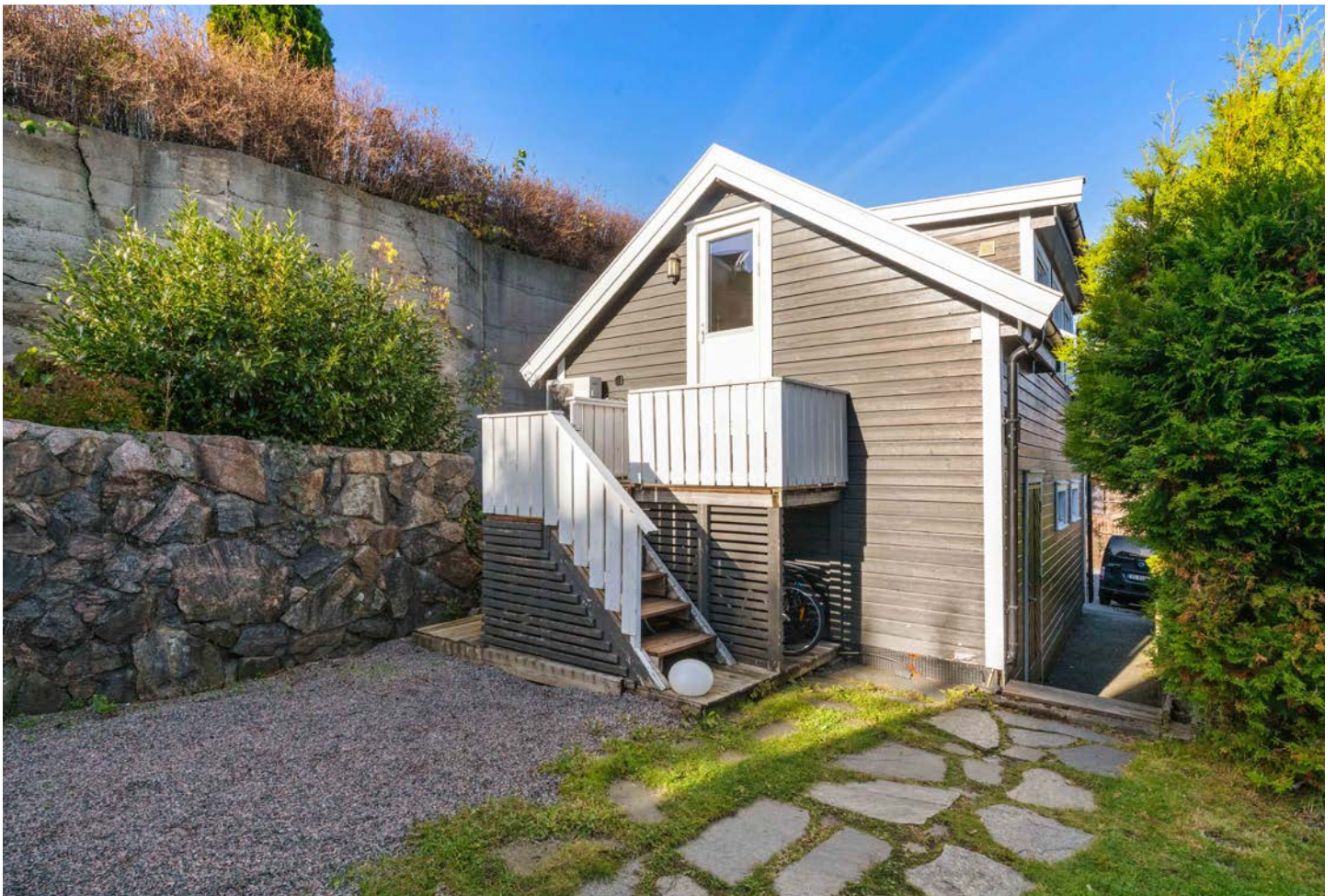
Tilhørende garasje med innredet rom på loft. Inneholder bad og hybelkjøkken(ikke søkt godkjent hos kommune).
