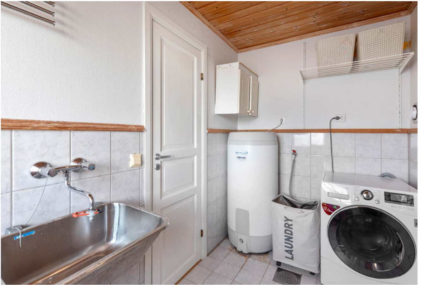
Vaskerom med opplegg for vaskemaskin
