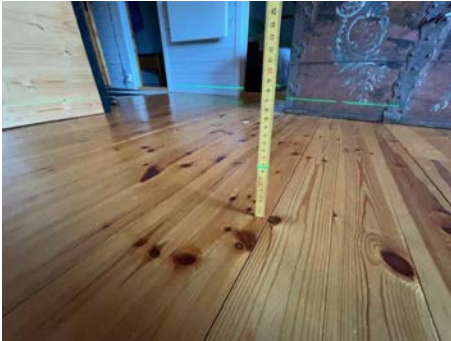
Utkastrek på laser er 11 cm på målestokk. Bilde viser ca. 25 mm høydeforskjell innefor 2 meter i stue.
