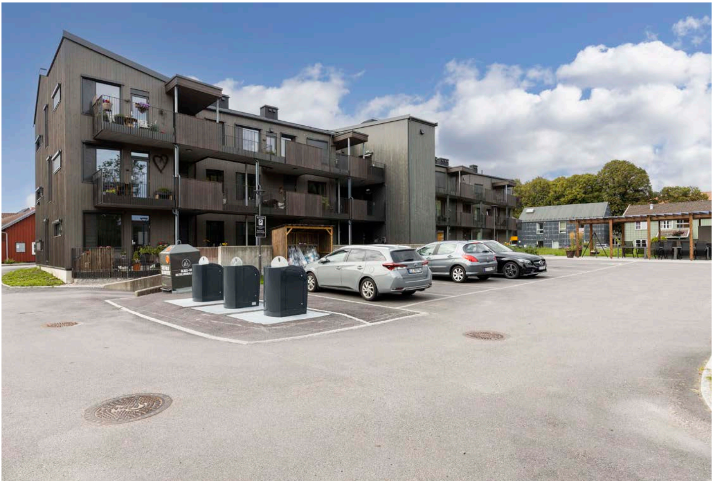
Felles parkering utenfor leilighetsbygget.
