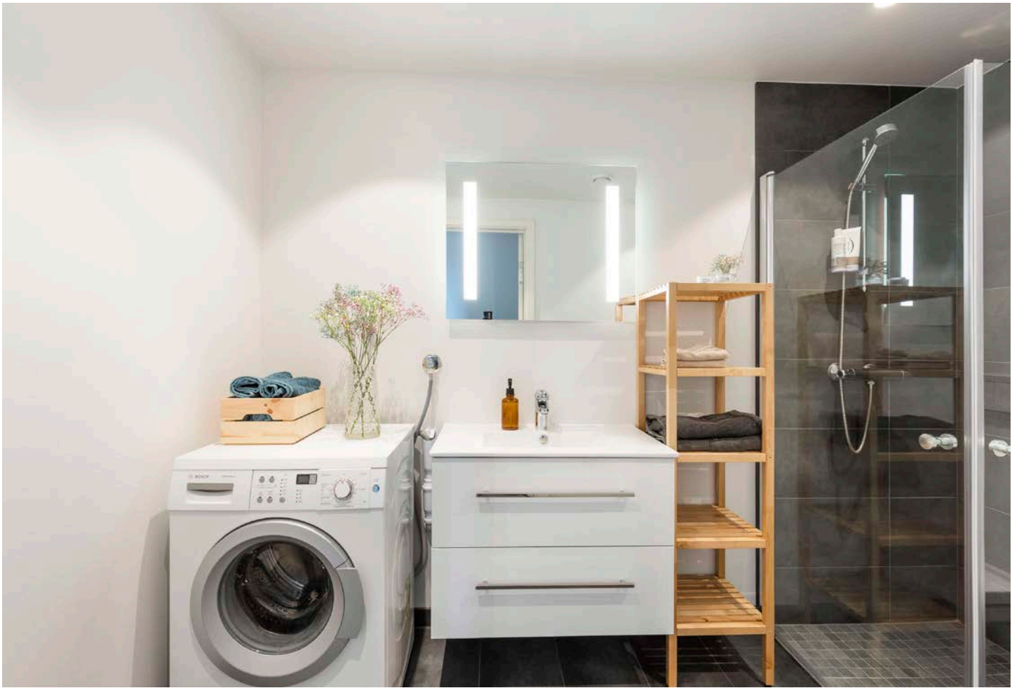
Bad/vaskerom med flis på gulvet, malt strie på veggene og malte slette overfalter i himlingen.
