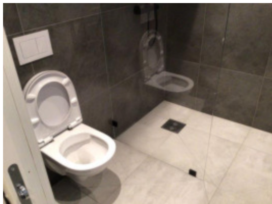
Wc og del av dusjnisje.
