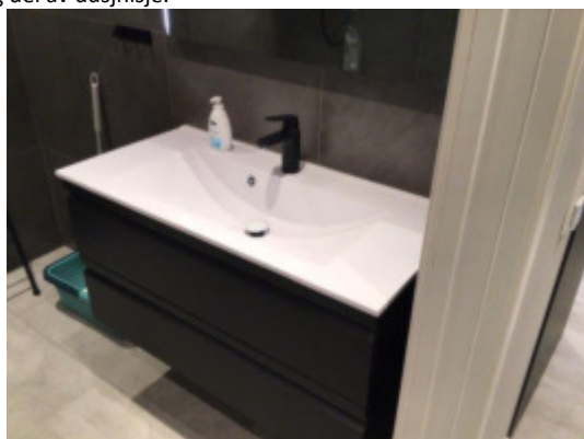
Montert innredning med håndvask.
