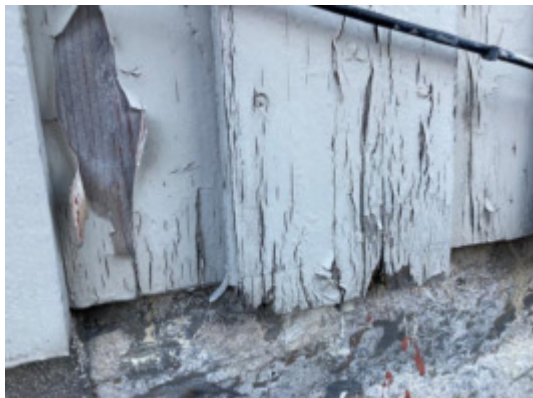
Råteskadet bordkledning på vegg mot vei.
