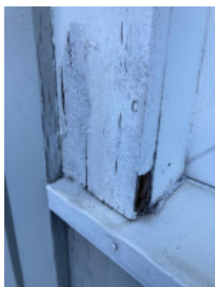
Råteskadet bordkledning på vegg mot vei.
