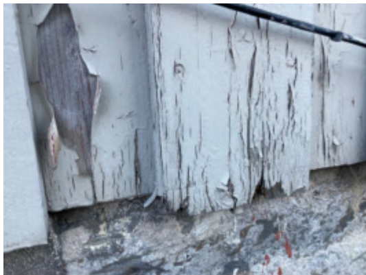
Råteskadet bordkledning på vegg mot vei.
