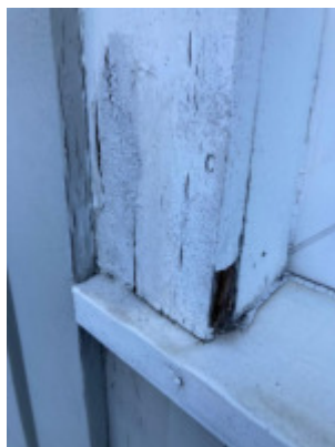
Råteskadet bordkledning på vegg mot vei.
