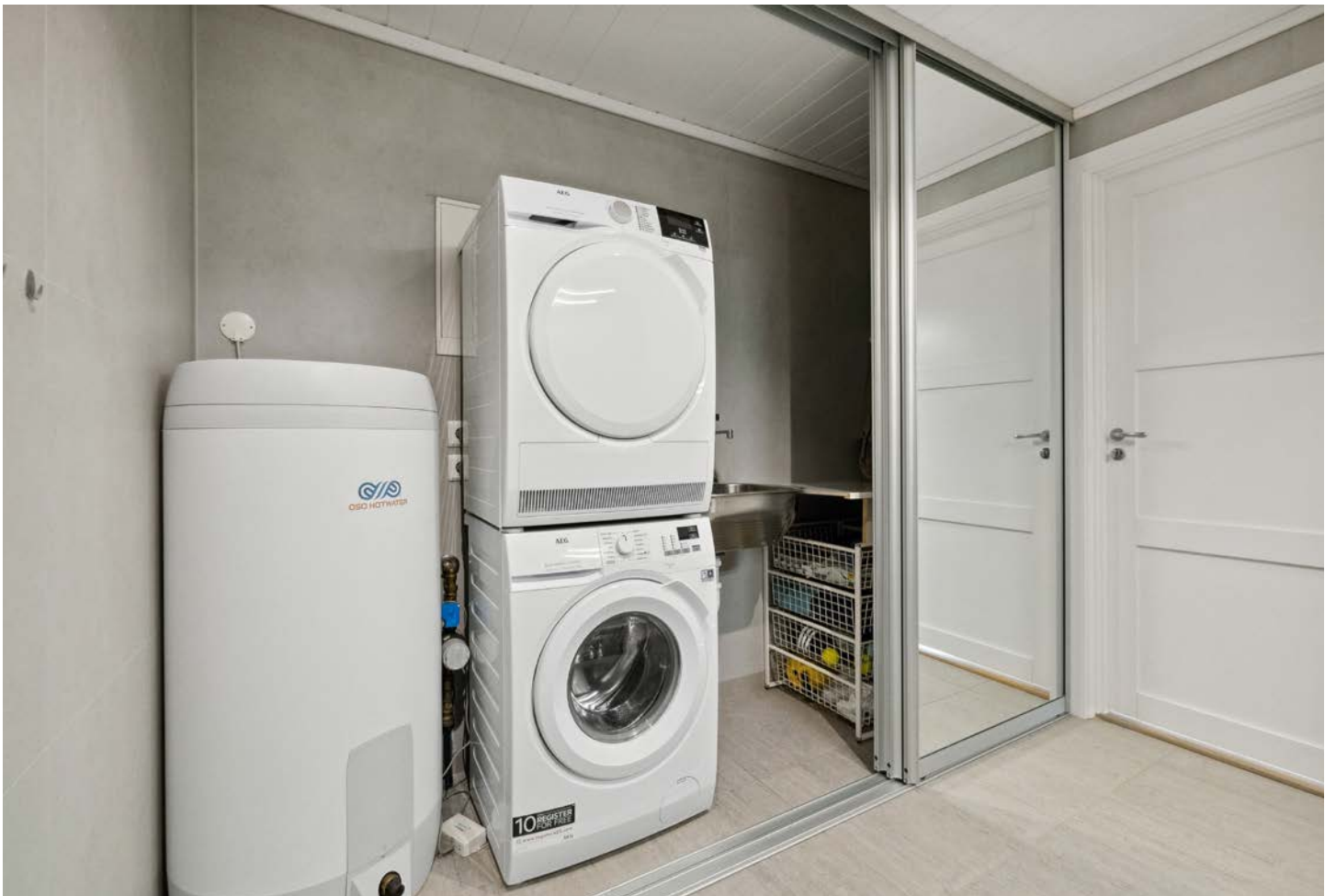
Bad/ vaskerom 1. etasje
