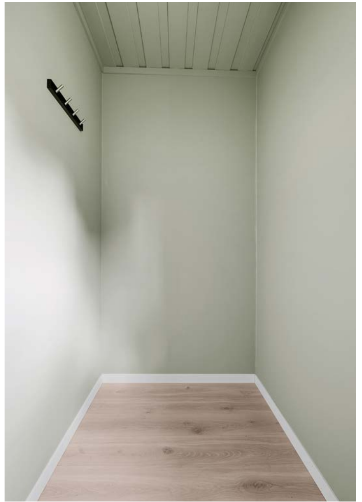
God plass til oppbevaring i den innerste delen av vindfanget.
