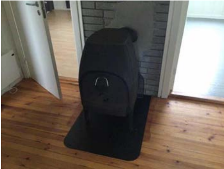
Montert ovn i gang 1 etasje.
