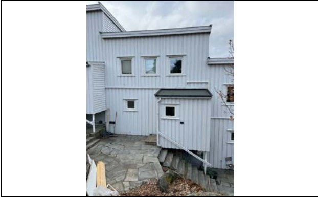
Fasadebilde tatt på befaring 18.03.2024
