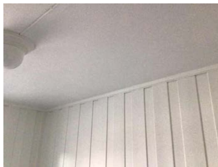
Eksempel på innvendige flater.
