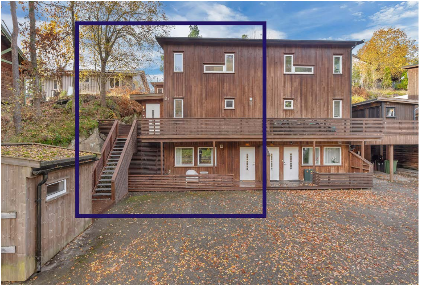
Boligen er godkjent med en boenhet. Det foreligger avslag fra kommunen vedrørende opprettelse av egen boenhet i underetasjen.
