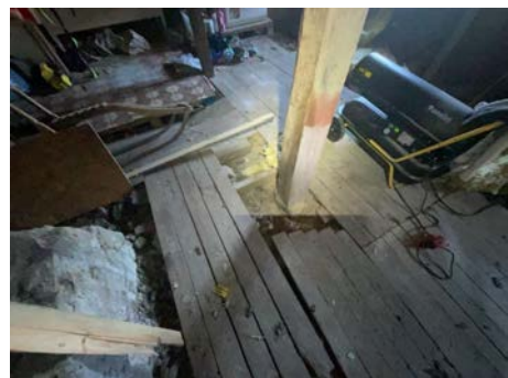
Bilde viser eks. på bæresøyle/bjelke rett ned på bakken/terreng i grovkjeller
