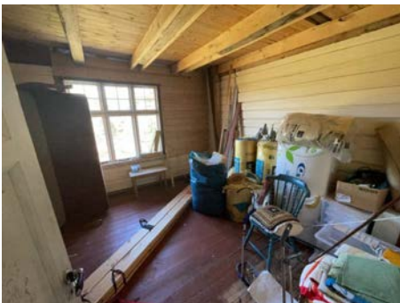
Bilde viser eks. på uferdig, delvis uinnredet rom i 2. etasje
