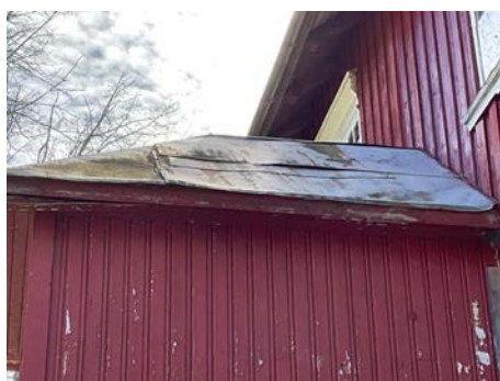
Bilde viser yttertekkingen på trappehuset.
