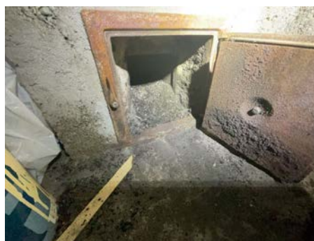
Bilde viser eks. på en del sotansamling nederst i pipa
