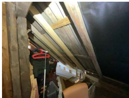
Bilde viser utbedret takkonstruksjon etter tidligere skade/lekkasje
