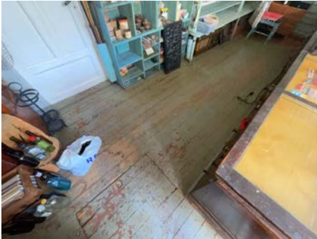
Bilde viser eks. på slitasje på gulv i bruksbelastet område.
