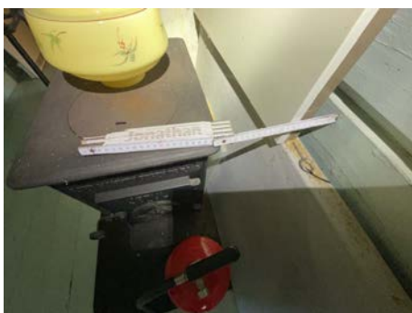
Bilde viser eks. på brennbart materiale nærmere enn 30 cm fra ildsted
