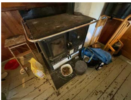
Bilde viser eks. på brennbart materiale nærmere enn 30 cm fra ildsted
