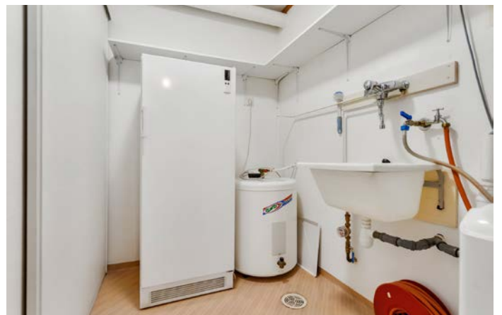
Praktisk vaskerom med belegg på gulv. Opplegg for vaskemaskin.
