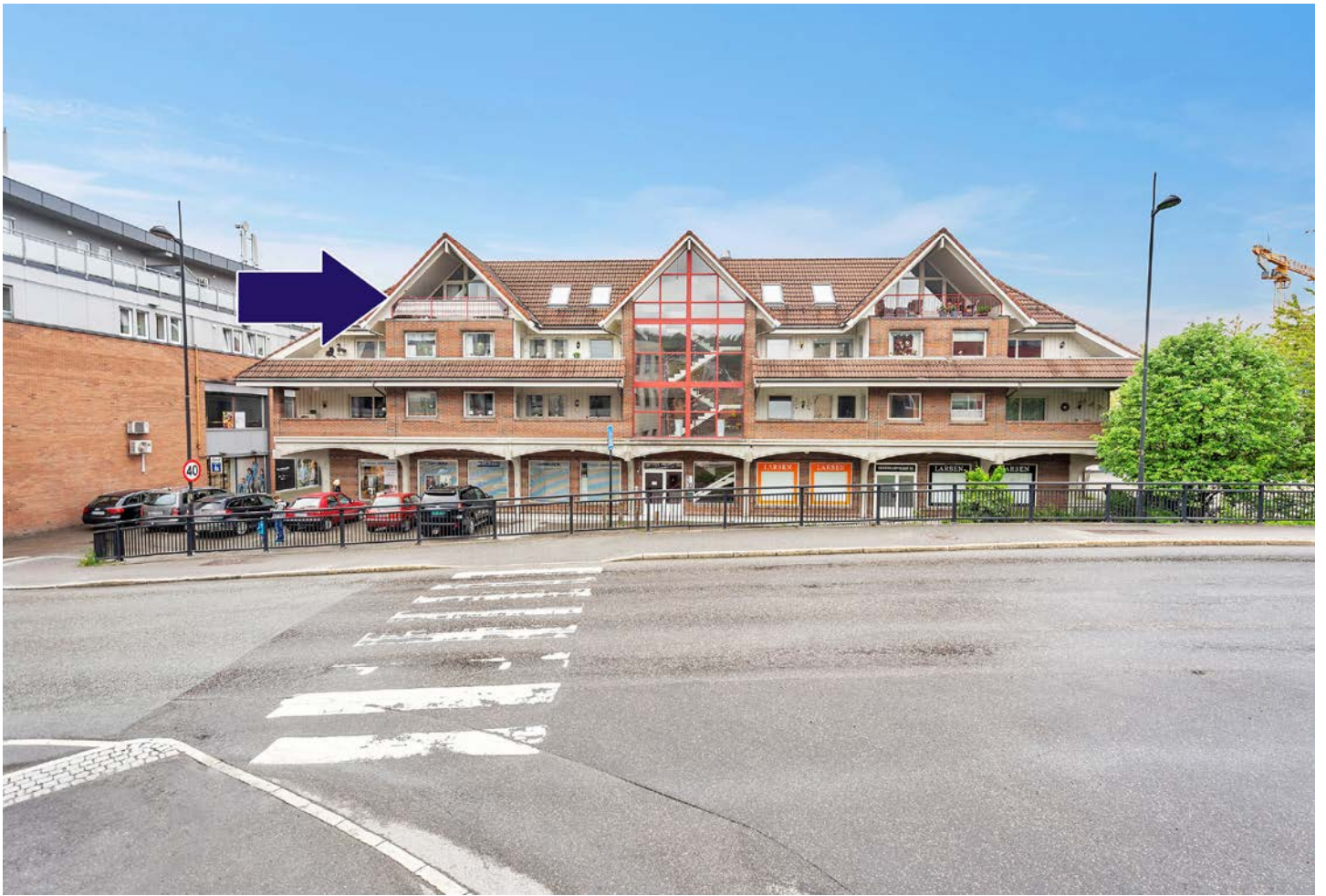
Leiligheten ligger i 4. etasje og har alt på en flate. Heis i bygget.
