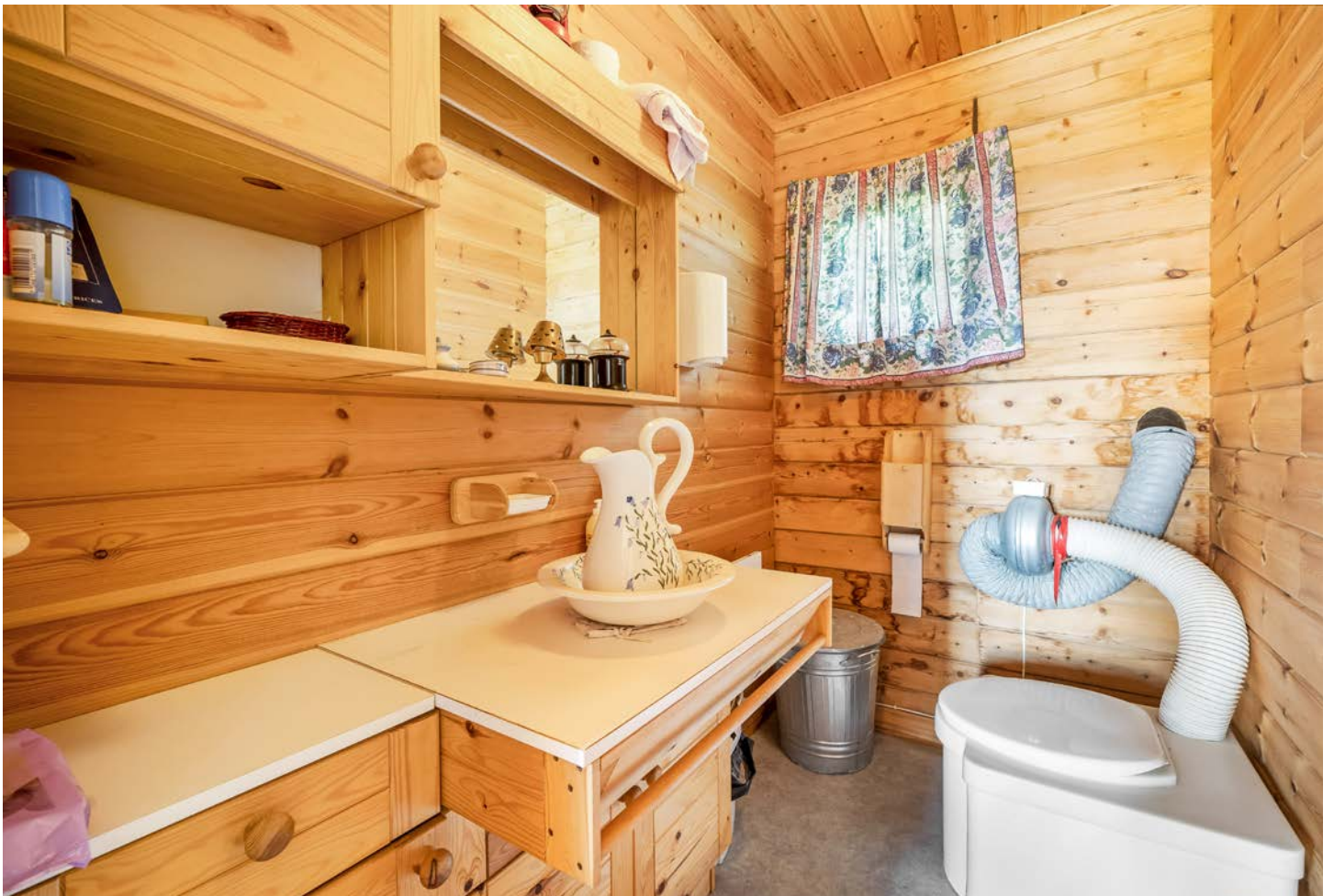
Badet har molldo med avtrekk ut.
