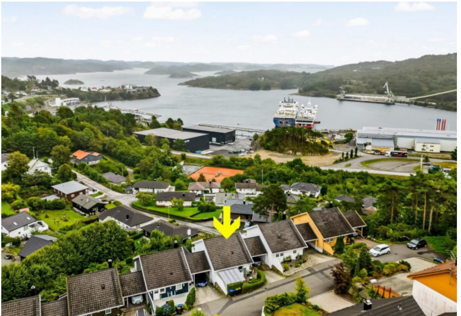
Oversikt fra bakside bolig og gaten.
