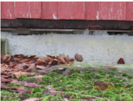
Åpen konstruksjon under kledning, ved oppgang til veranda
