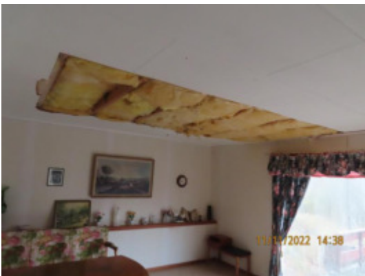
Del av himlingsplater i stue/kjøkken er fjernet
