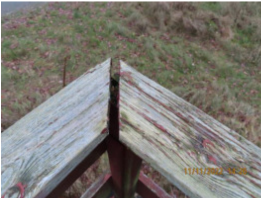
Det er registrert råteskade i rekkverkstolper
