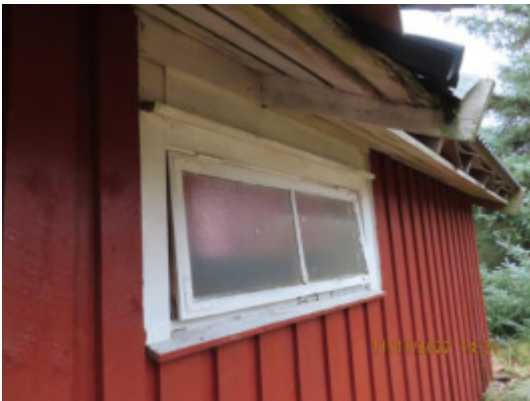
Vindu på bad
