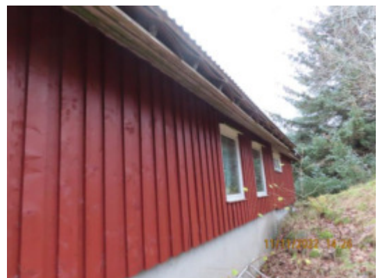
Stedvis terrengfall mot bygning
