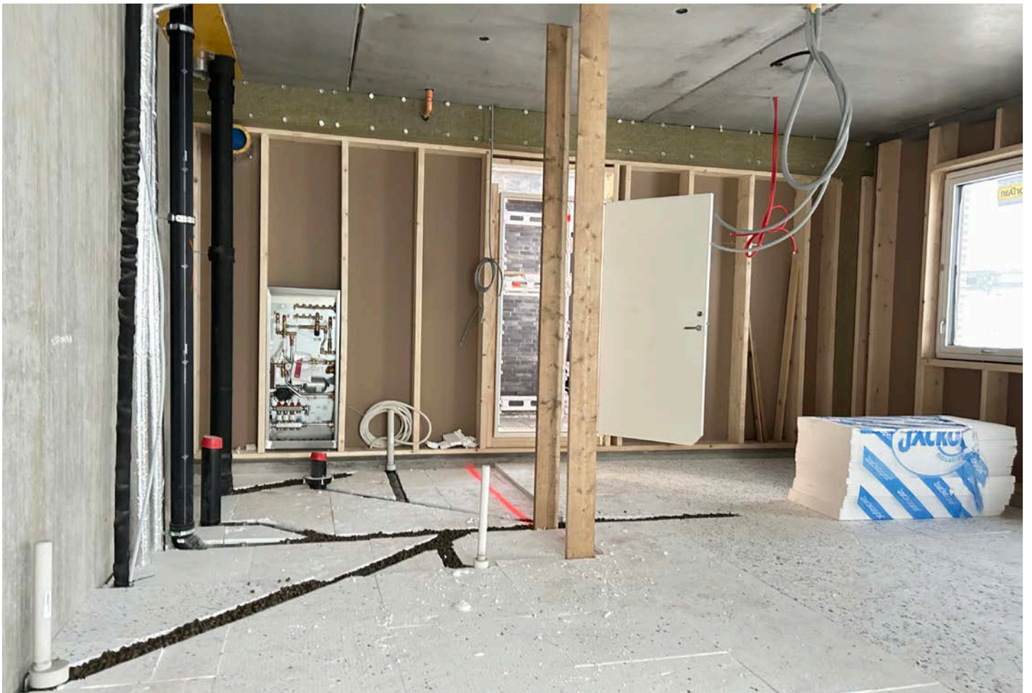
Kjøkken kommer på vegg mot bad
