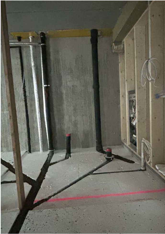
Bad under oppføring
