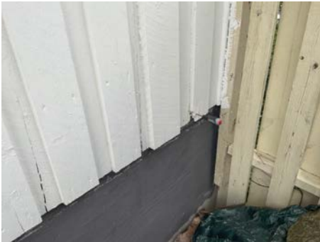
Mindre råteskade.
