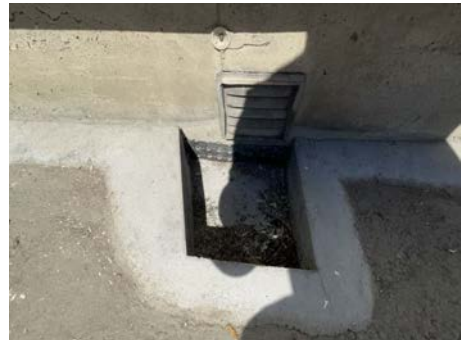
Fuktsikring mot vei.
