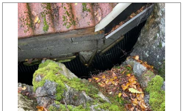
Grunnmursplast registrert mot fjellside
