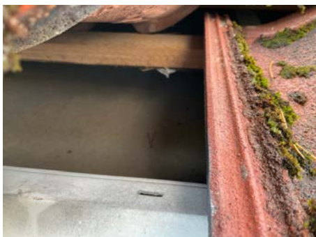
Stikk kontroll av undertak
