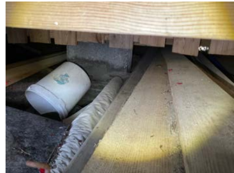
Murte/støpte fundamenter registrert stedvis
