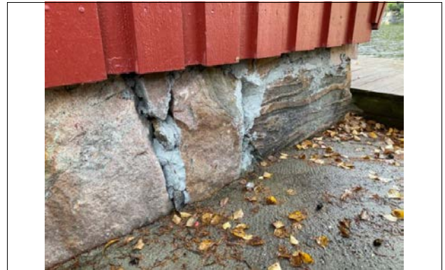
Murte stablestein som grunnmur/fundament
