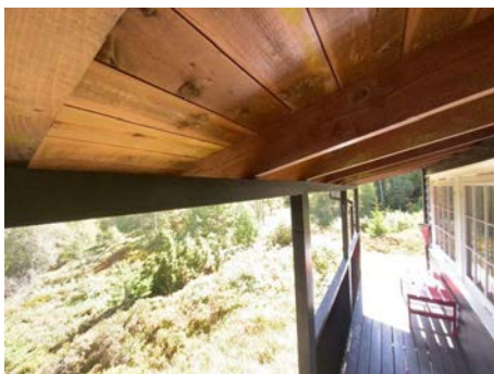
Dragere under sperrer er noe underdimensjonert.
