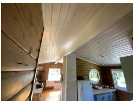
Dragere under sperrer er noe underdimensjonert.
