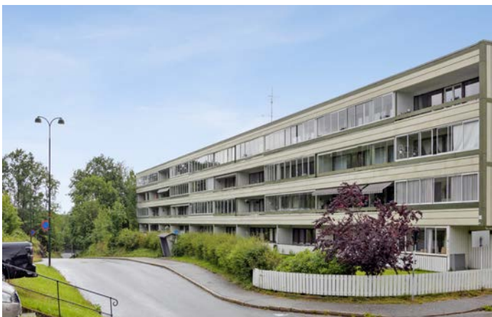
Fasade - Leiligheten ligger helt opp i venstre hjørne
