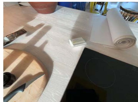
Tape til komfyrvakt har løsnet fra ventilator.
