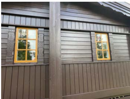
Eksempel på vindu i yttervegg.
