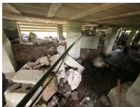
Vannrør under hytta.
