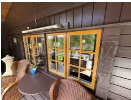
Eksempel på vindu i yttervegg.
