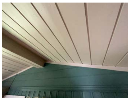
Del av vegg - tak.
