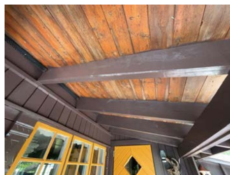
Konstruksjon sett fra terrasse.
