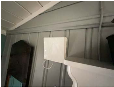
Eksempel på montert ventil i vegg.
