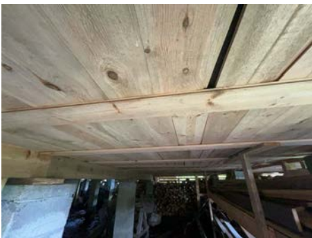
Del av etasjeskille sett fra undersiden.
