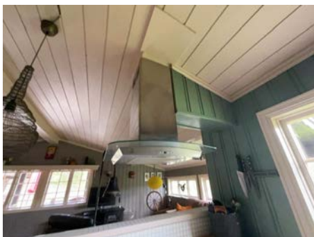
Montert avtrekk over komfyr.
