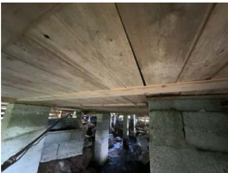
Del av etasjeskille sett fra undersiden.
