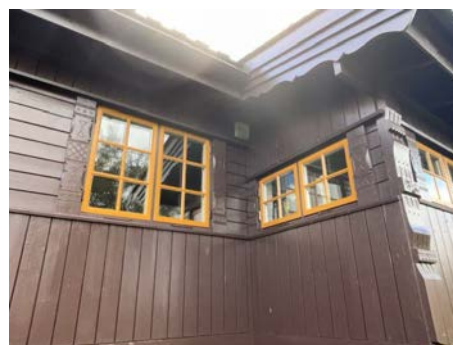
Eksempel på vindu i yttervegg.
