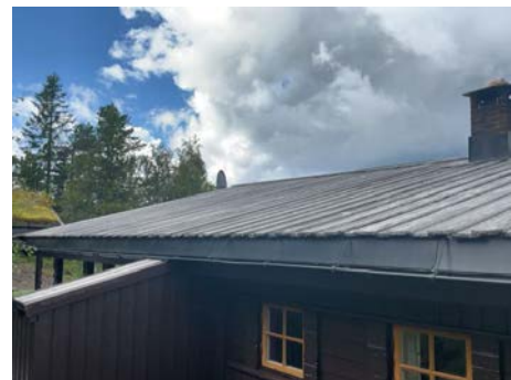
Del av taktekkning.
