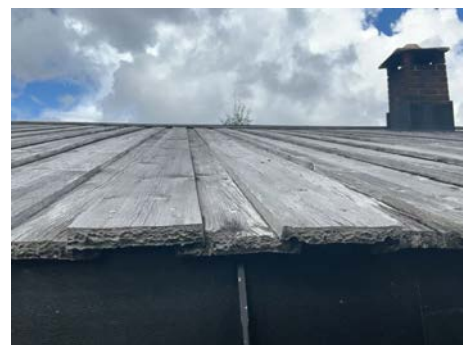
Del av taktekkning.
