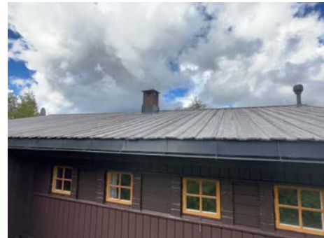
Del av taktekkning.
