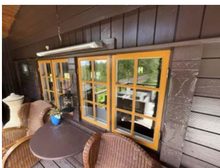
Eksempel på vindu i yttervegg.
