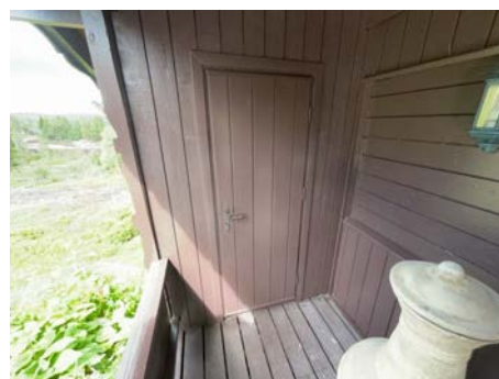
Dør inn til bod.
