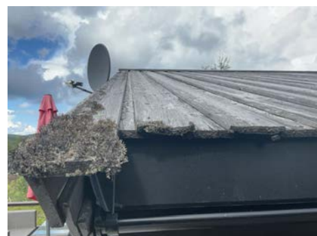
Del av taktekkning.
