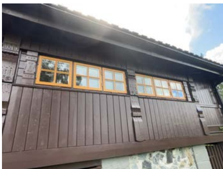
Eksempel på vindu i yttervegg.
