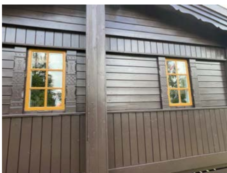
Eksempel på vindu i yttervegg.
