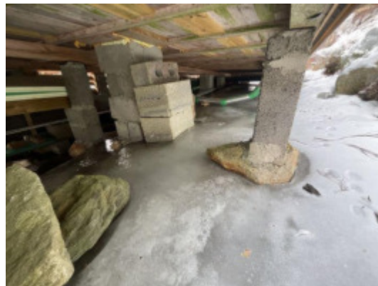
Utsnitt fundamenter og pilarer.
