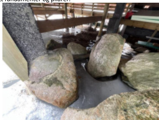
Utsnitt fundamenter og pilarer.
