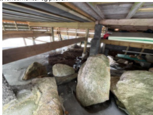
Utsnitt fundamenter og pilarer.
