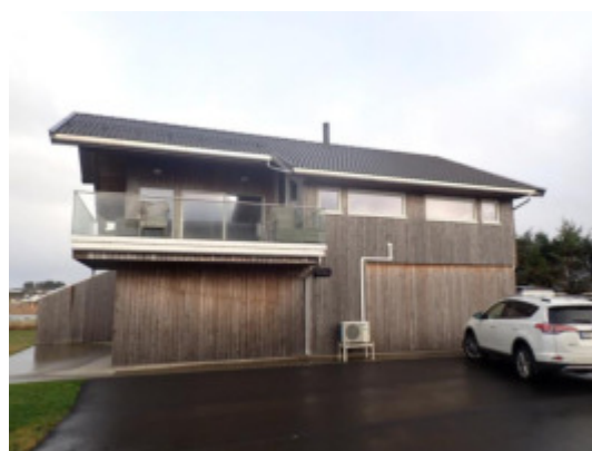
Det er snøfanger på tak ved terrasse
