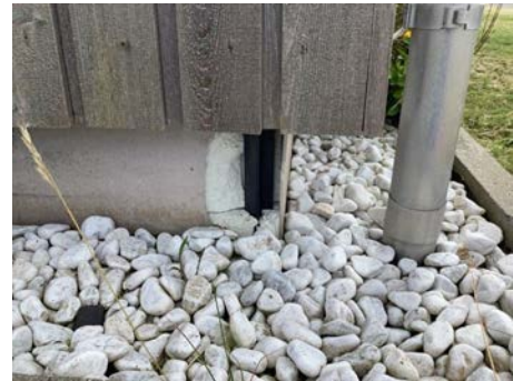
Skade på grunnmurelement
