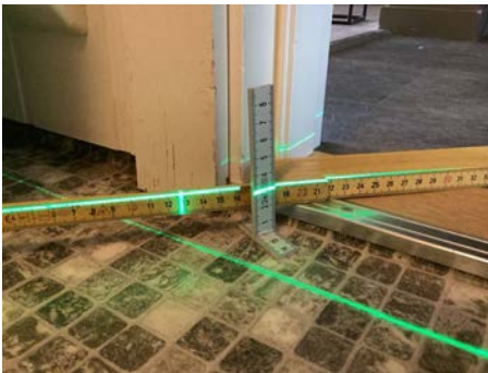
Måling ved terskel
