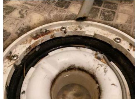
Påvist belegg under klemring
