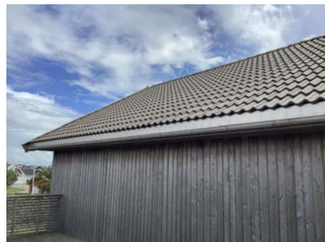
Denne takflaten tilhører nabo, men man bør informere nabo om at det må monteres snøfangere.
