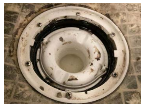
Påvist belegg under klemmring
