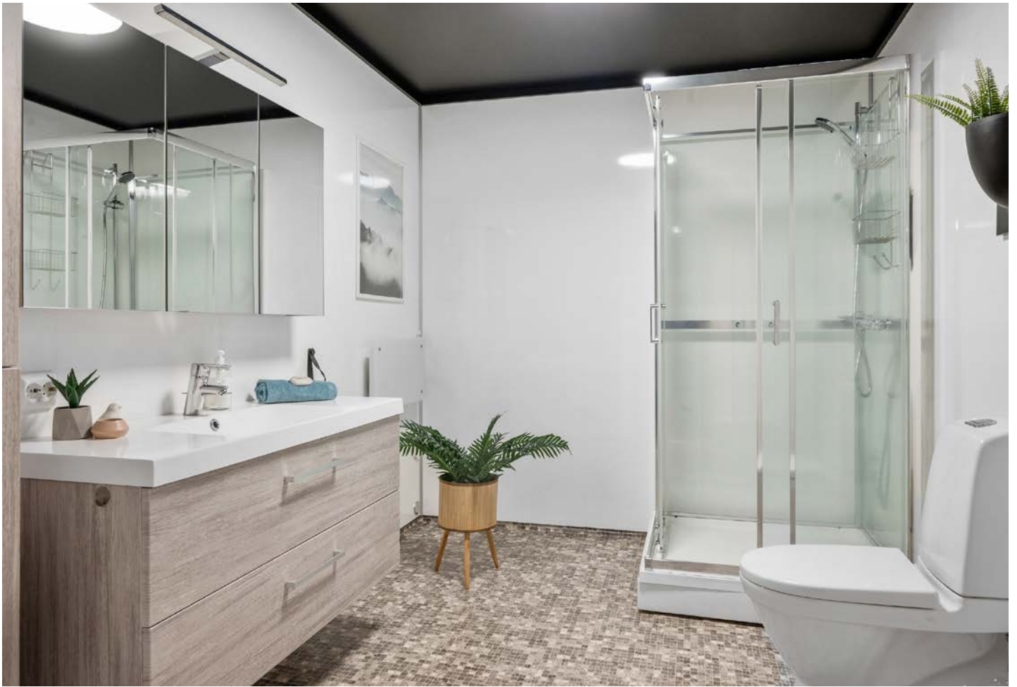
Delikat innredet bad med belegg på gulv og baderomsplater på vegg. Badet er innredet med baderomsinnredning, toalett og dusjkabinett.
