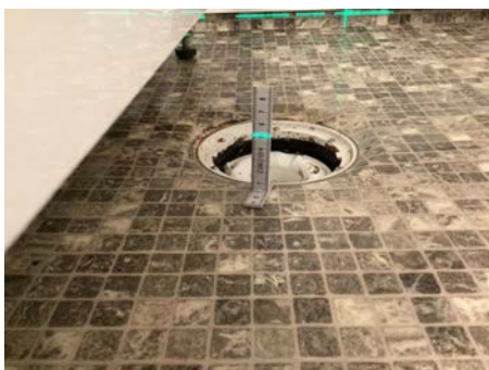
Måling ved sluk
