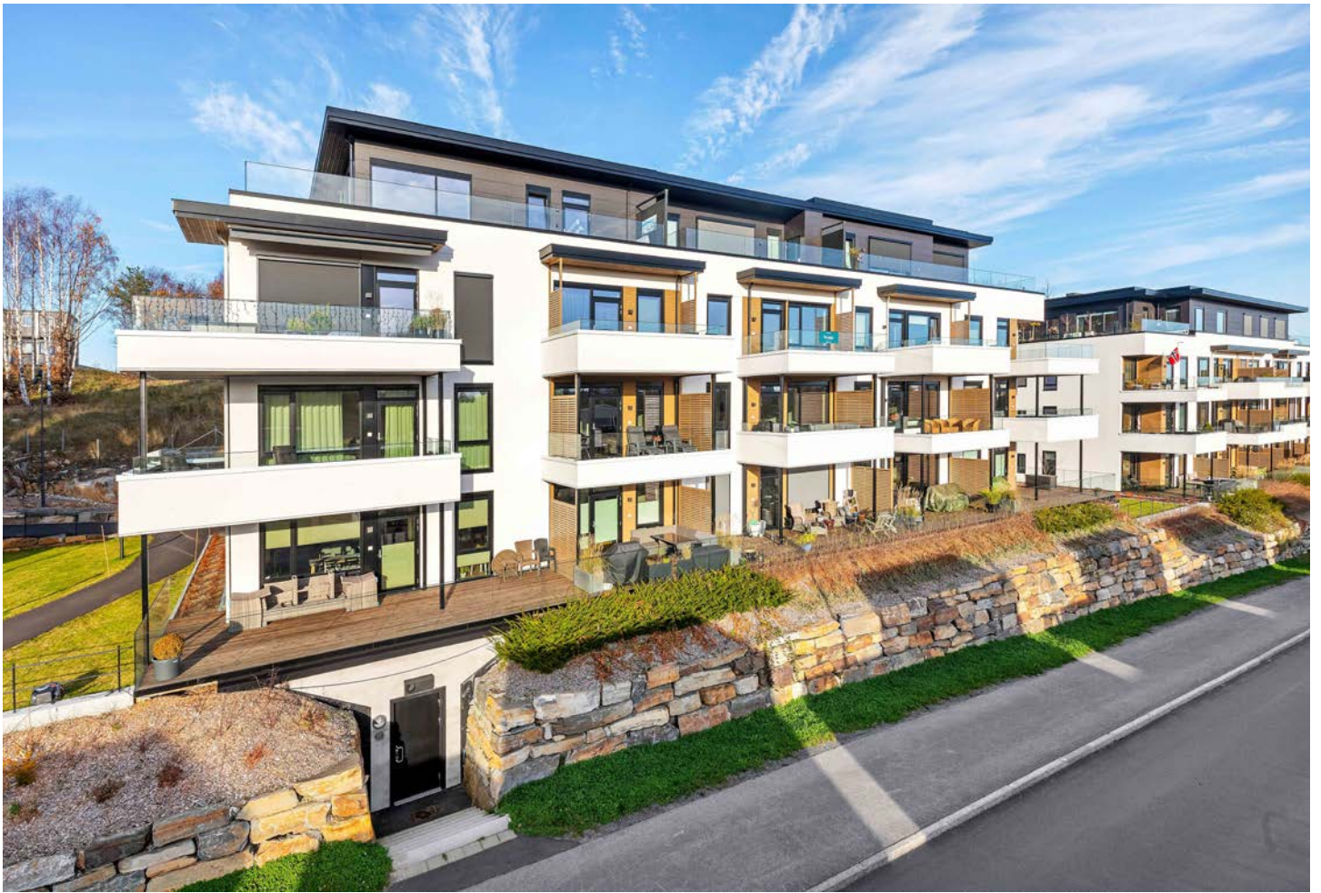
Fasade av leilighetsbygget hvor en ser leiligheten i front her i 2. etg.
