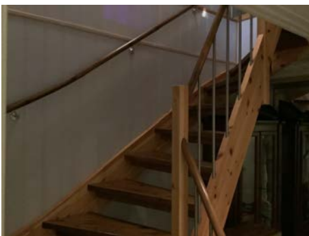
Trapp fra underetasje til 1. etasje.
