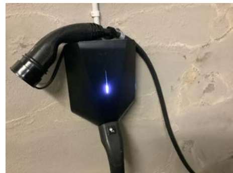
El-bil lader montert i garasjen i boligen.
