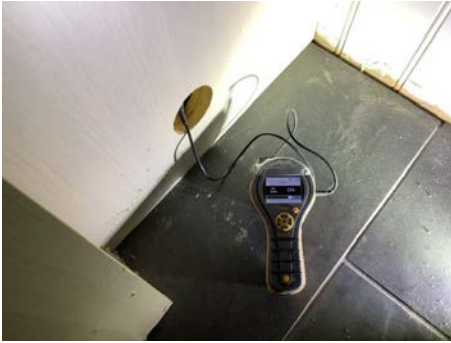
Hulltaking i vegg.
