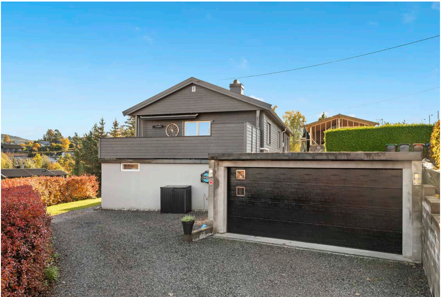
Frittstående dobbelgarasje med flatt tak, samt eldre garasje under terrassen - denne brukes til lagring av utstyr
