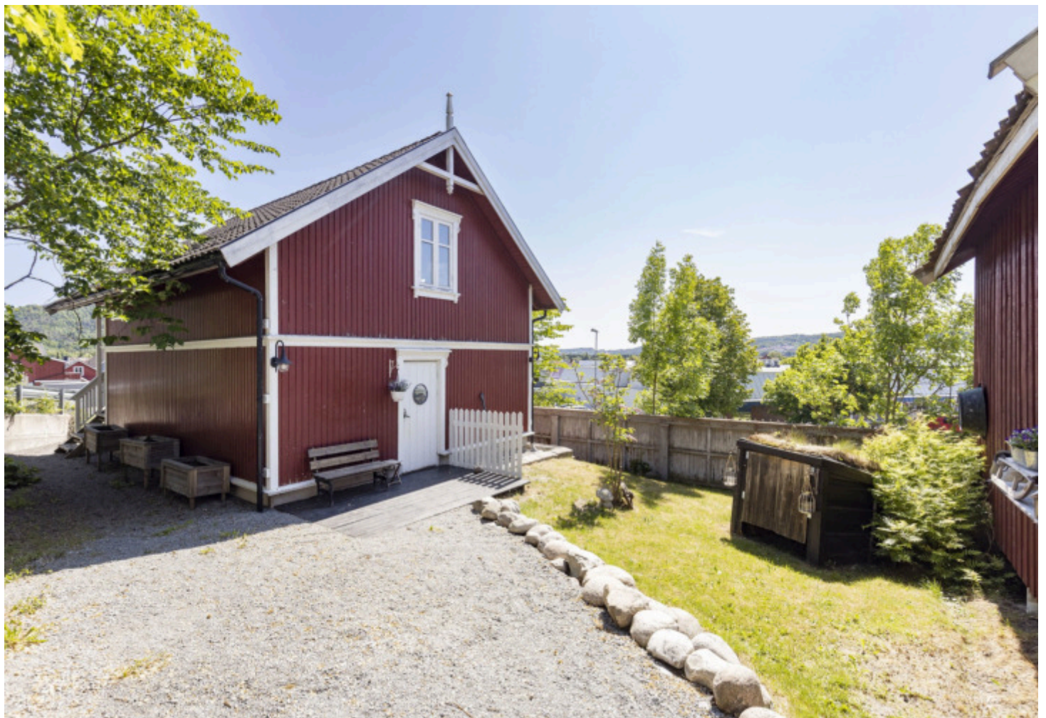
Garasjebygg er oppøft i 2001
