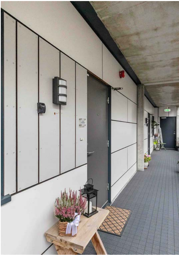
Svalgang på baksiden av bygget
