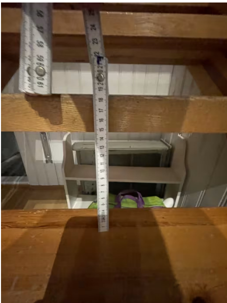
Åpninger mellom trinn er over 10 cm.
