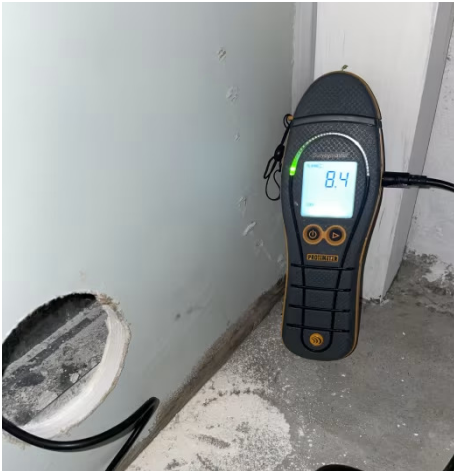
Ingen unormale fuktverdier i vegg.
