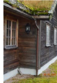
📌 TG 1 Utvendige vann- og avløpsledninger
