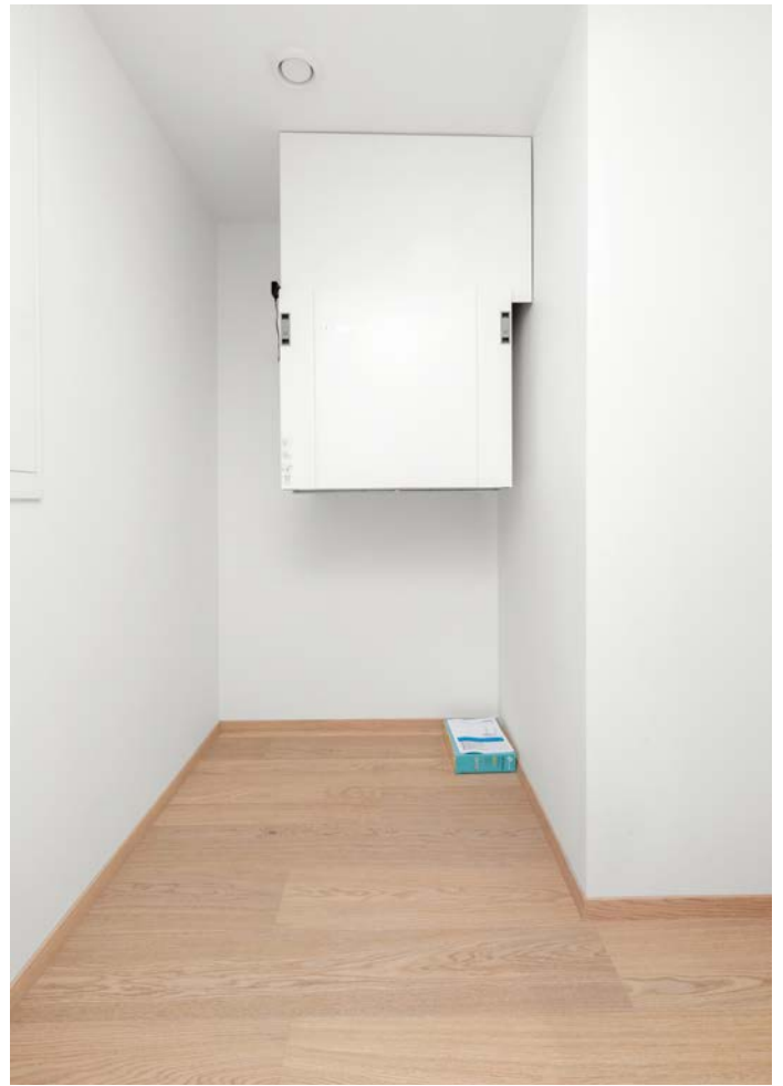
Innvendig bod/ tekniske rom
