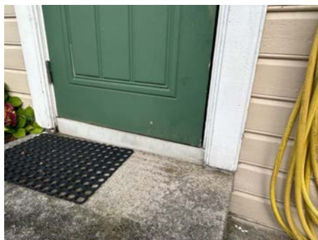
Dør fra teknisk rom/bod
