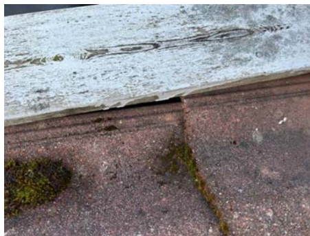
Takstein er ikke tilpasset vannbordet
