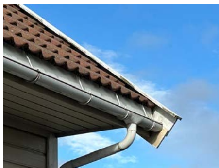
Takstein er ikke tilpasset vannbordet
