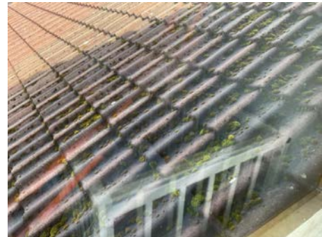
Mose på taktekking.
