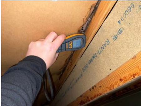
Fuktmåling i sperre.
