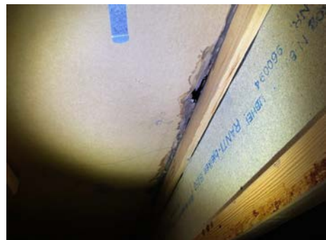
Hull i undertak.
